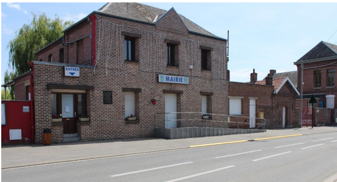
Photographie 23 : La mairie de Ramillies.
