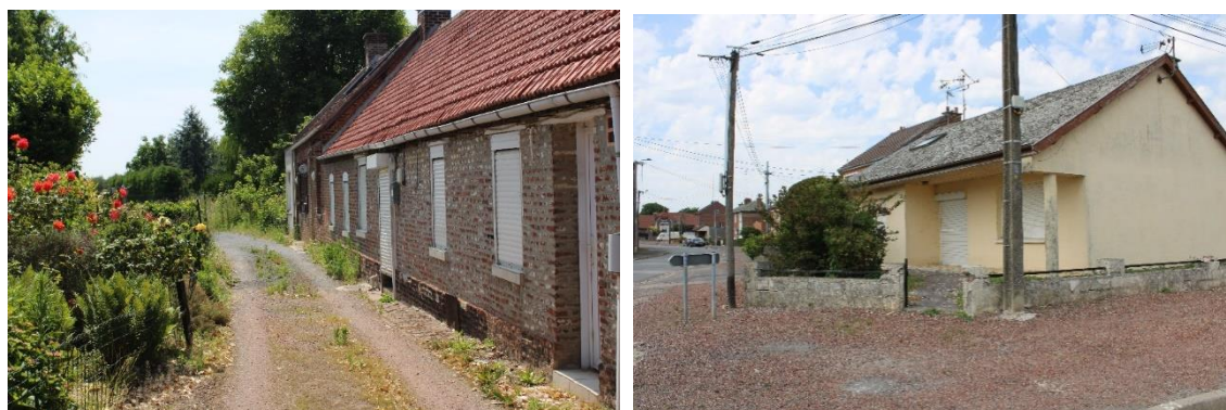
Photographie 49 - Logements potentiellement vacants.
